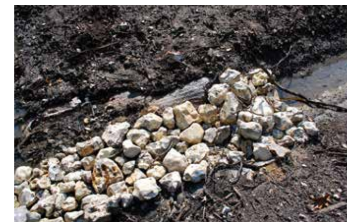
Exemple de positionnement des pierres
