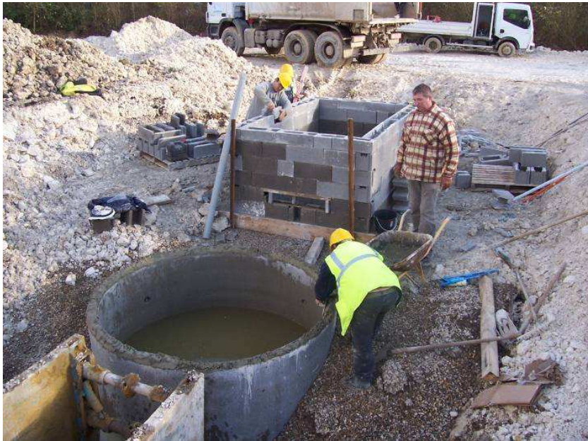
Figure 5 : Travaux de création du poste de refoulement Aire d'accueil des gens du voyage
