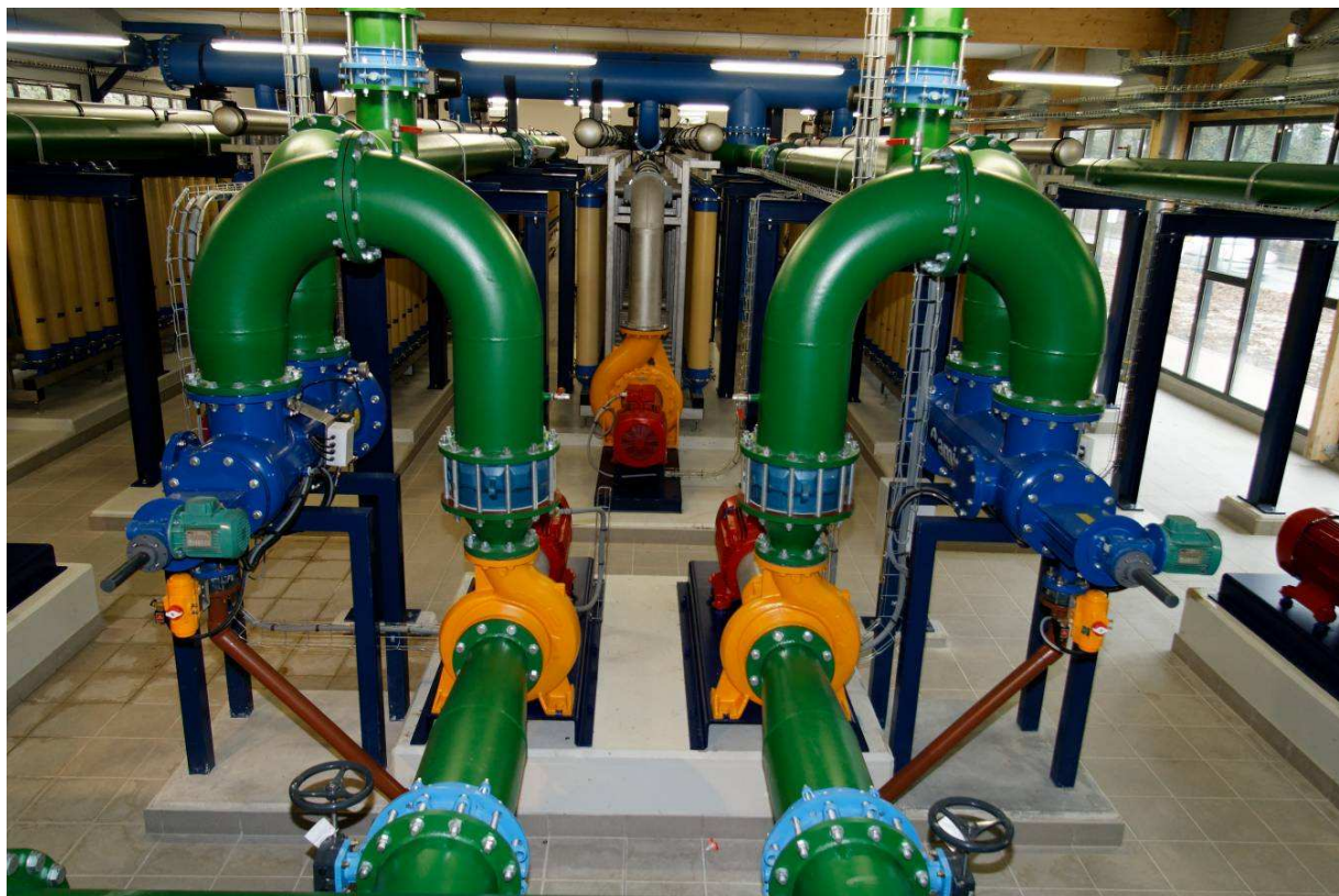
Usine de Moulineaux – vue intérieure
