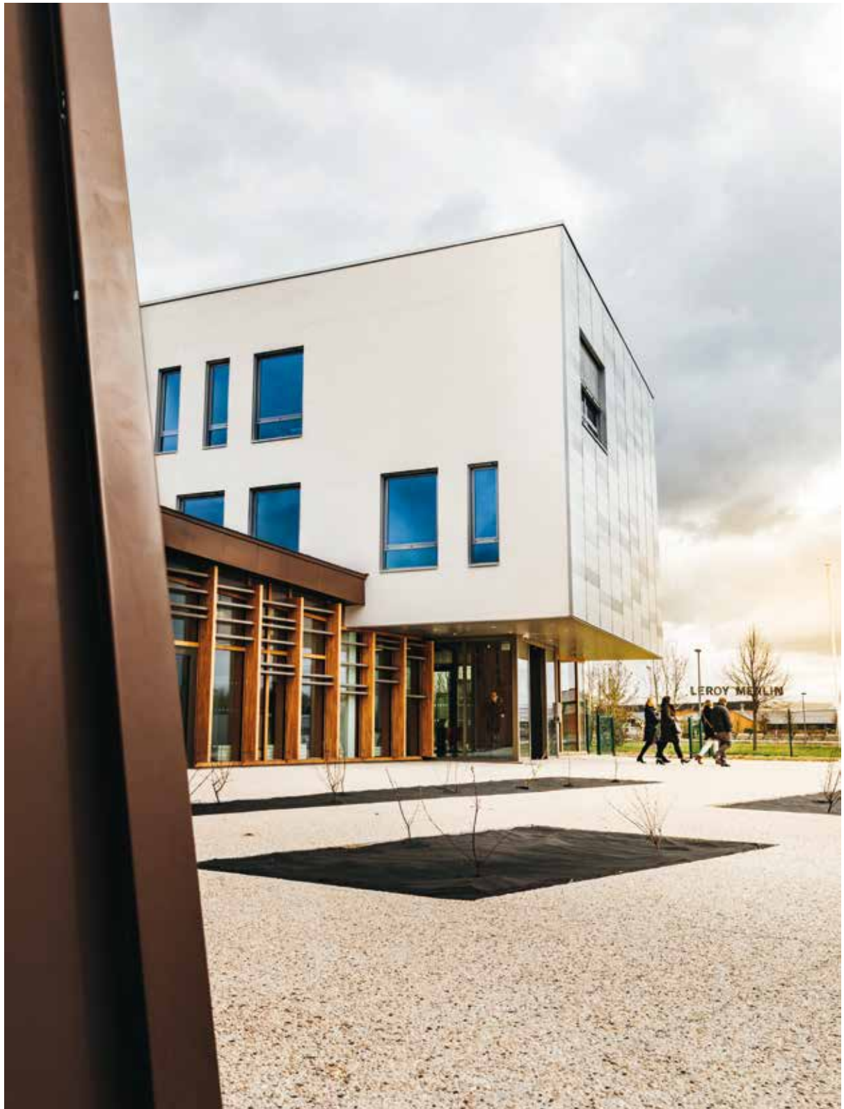
> Le nouveau site du Centre de Gestion 76.
