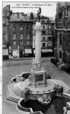
C'est dire que la rive gauche DÉPLACEMENT À LA VICTOIRE PLACE FOCH AVANT SON DÉPLACEMENT
