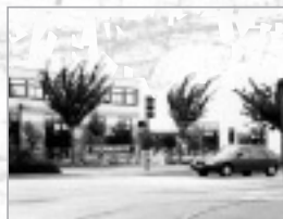
LE TECHNOSITE DES BRUYÈRES
