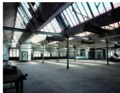
Ateliers en shed des Ets Weill Bernheim et Kinsbourg, 36 rue du Gal de Gaule à Elbeuf. Photo C. Kollmann © 1993 Inventaire général.
