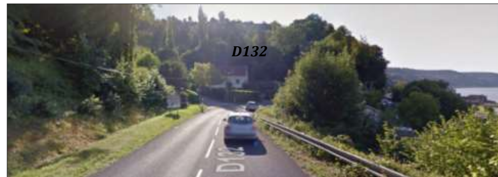
Figure : Illustrations photographiques des entrées de ville / Source : Google
