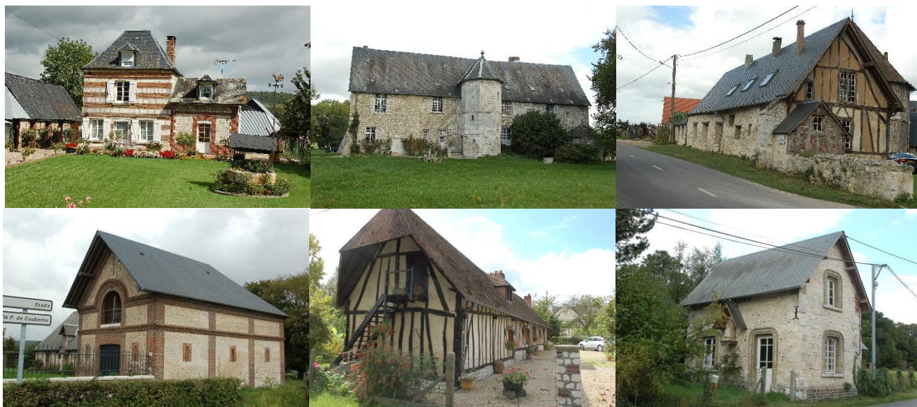
Figure 63 : Exemples de constructions de qualité à Anneville-Ambourville
