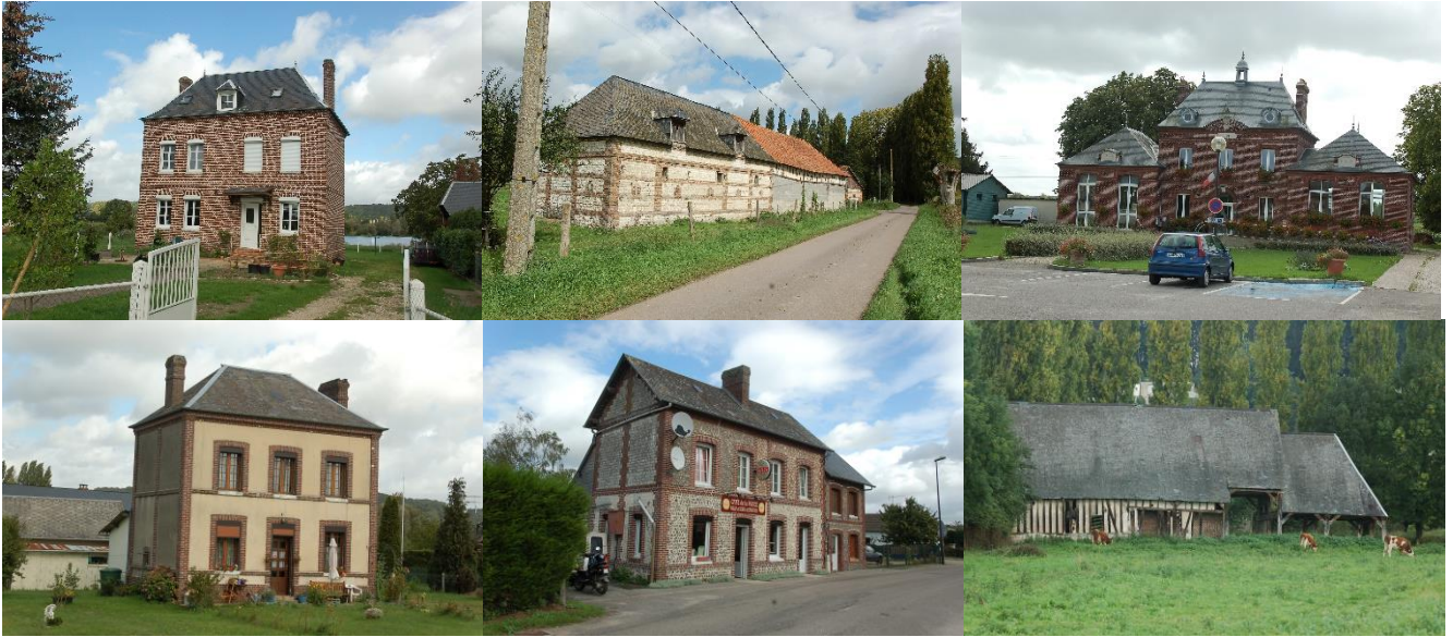
Figure 64 : Exemples de constructions de qualité à Berville-sur-Seine
