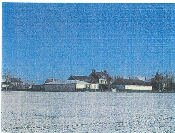
Vue sur des arrières de bâtiments
