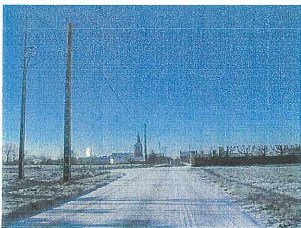
Accès Nord/Est (vue sur l'église)
