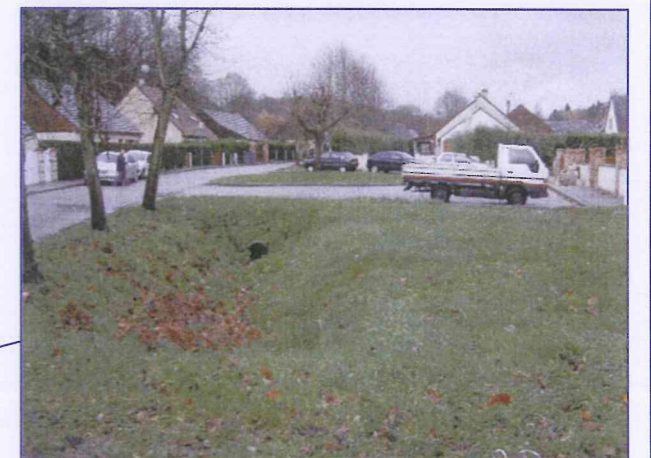
Vue du fossé d'assainissement dans le lotissement du Val Réal (aval)
