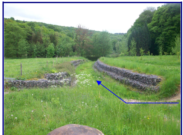
Ouvrage réalisé par le SMBVAS en aval de l'ouvrage sous la voie ferrée. Cet ouvrage guide les eaux de ruissellement vers l'Austreberthe
