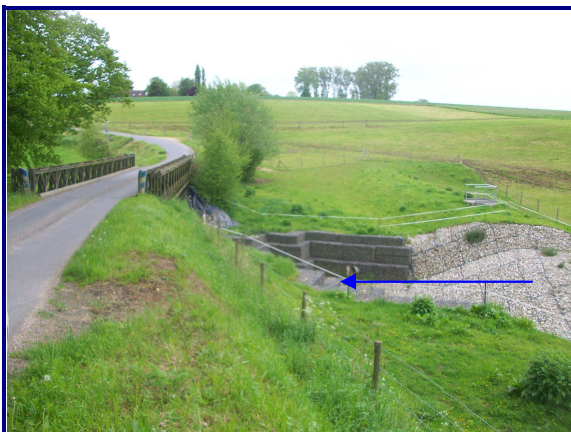
Suite à la démolition de la propriété en amont de la rupture de la route (photo 3b), un ouvrage a été réalisé par le SMBVAS.
