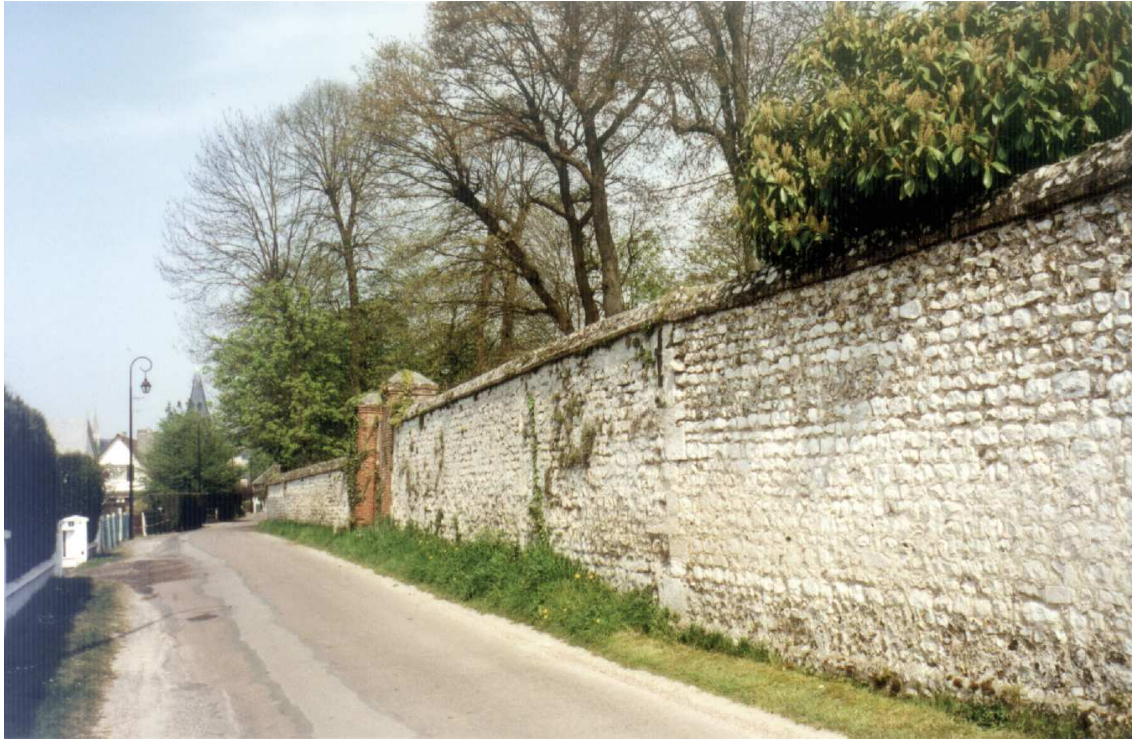
un mur en pierres avec piliers de briques
