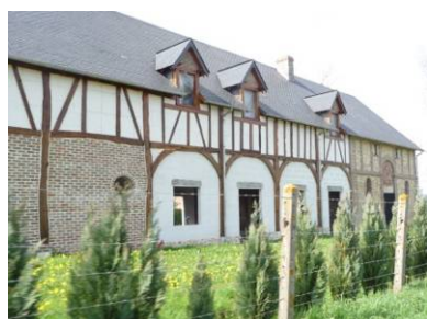
Granges rénovées, rue des Canadiens
