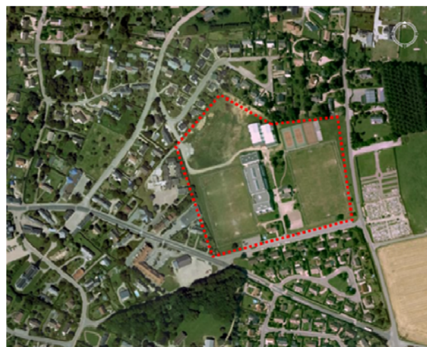
Les équipements sportifs occupent une surface très importante par rapport à la taille du village
