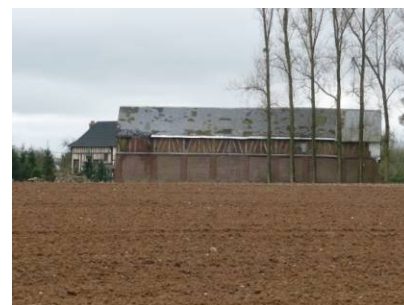
Granges rénovées, rue des Canadiens
