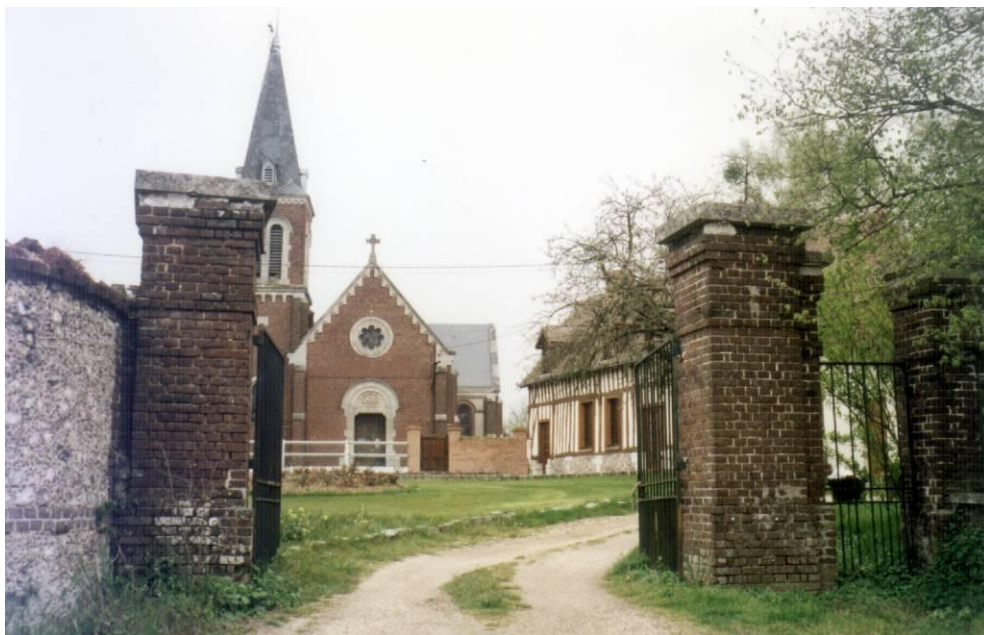
l'église de Saint-Aubin-Celloville, au travers d'une propriété ancienne
