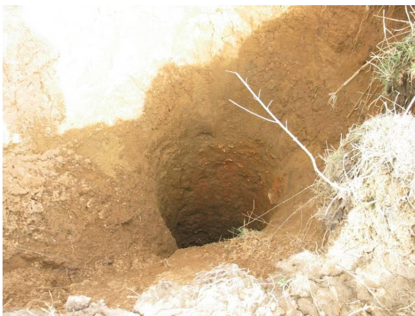
figure 10 : déboufrage de puits, commune d'Hattenville (76)
