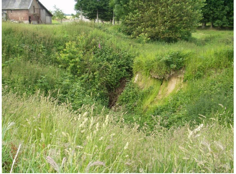
figure 11 : point d'infiltration (bétoire) sur la commune d'Hattenville (76)
