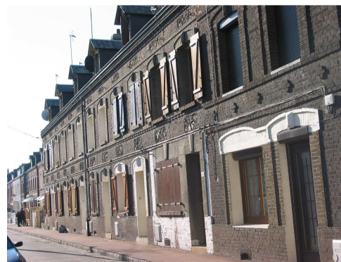
Maisons en bande et en briques rue Aristide Briand
