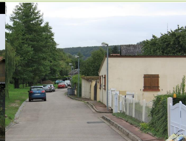
Prévoir un accès piéton chemin des Coquelicots ainsi qu'un point de collecte des déchets
