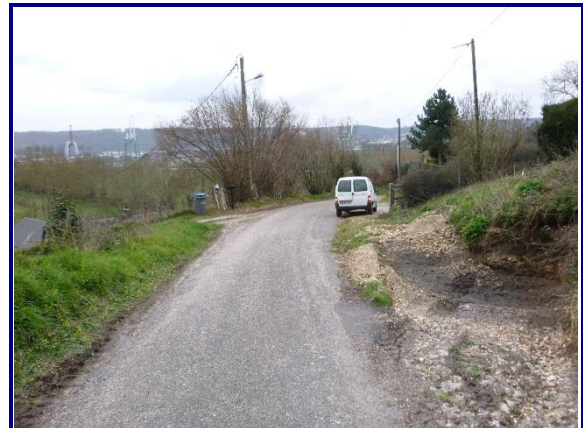
Empochement (créé par la commune) permettant l'infiltration d'une partie des eaux ruisselées.
