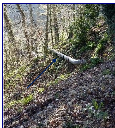
Canalisation rejetant les eaux en amont du cimetière
