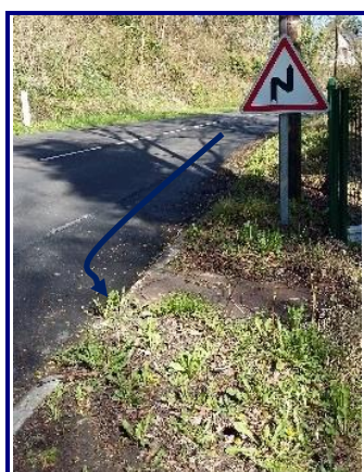
Grille avaloir interceptant une partie des eaux de la cote
