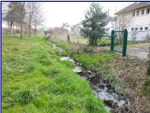
Le réseau eau pluvial de la commune se rejette dans ce réseau de fossé avant son exutoire en Seine
