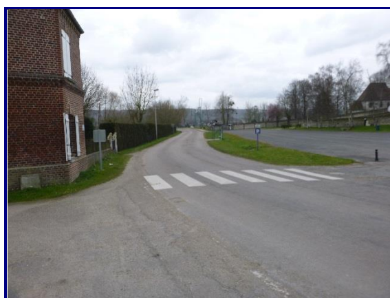
Lors de fortes pluies la RD51 inondent sous l'importance des ruissellements venant des rues Antonin, Farceaux et Rouage.
