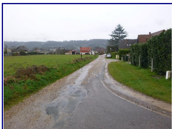
Erosion des accotements de la voirie engendrée par les ruissellements rapides sur la voirie
