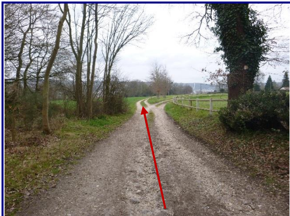
Erosion observée au niveau du chemin forestier entre Hautot sur Seine et Val de la Haye.
