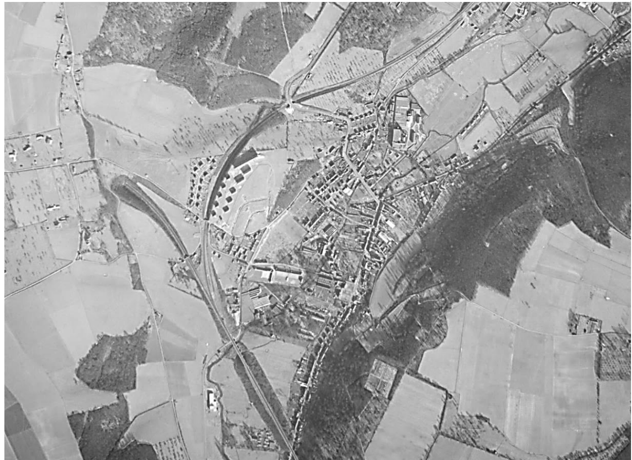
Figure 11 : Photographie aérienne du centre de Malaunay en 1963 (Source : IGN)
