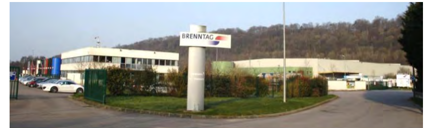
Figure 15 : Photographie des établissements BRENNTAG
