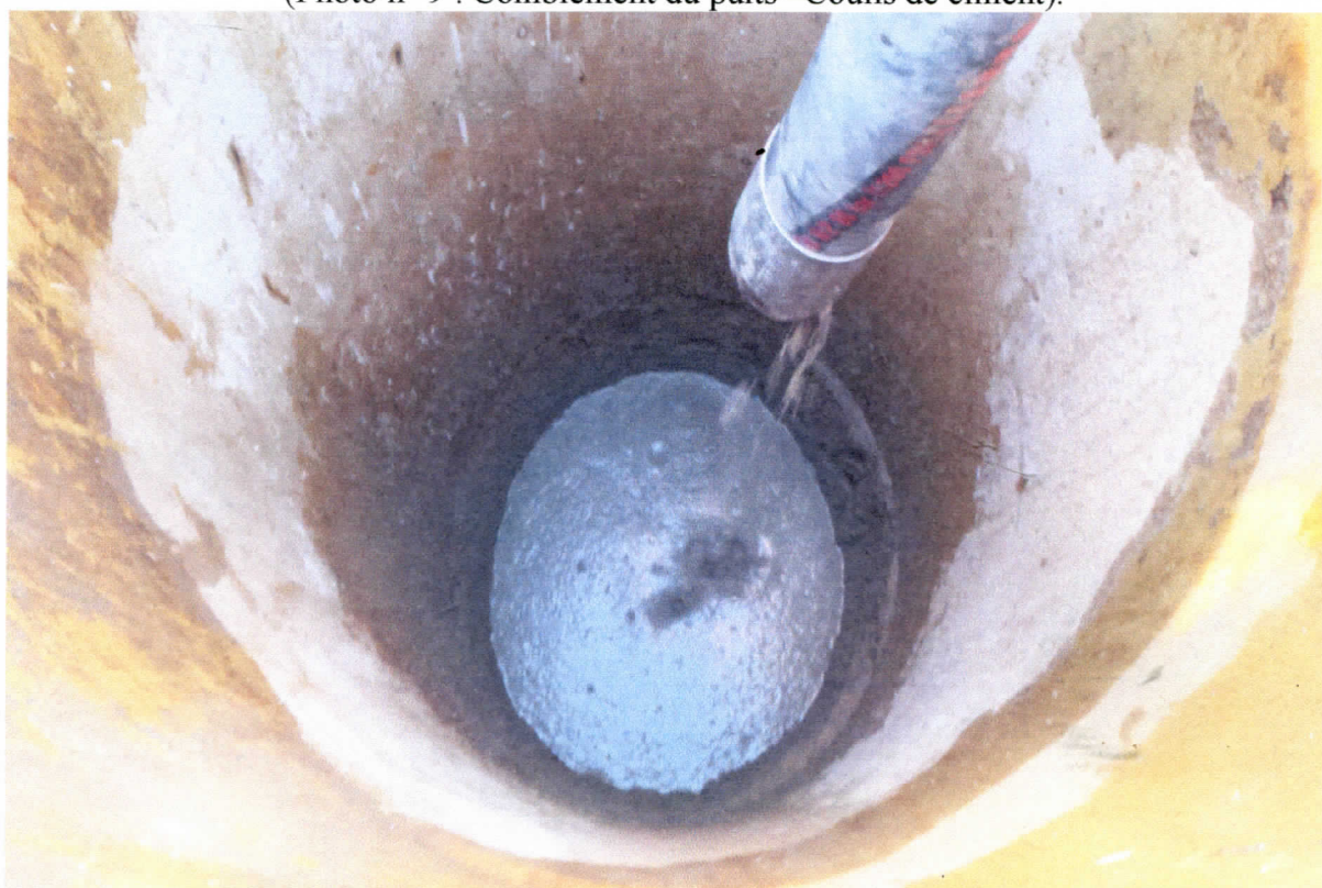
(Photo n° 9 : Comblement du puits –Coulis de ciment).
