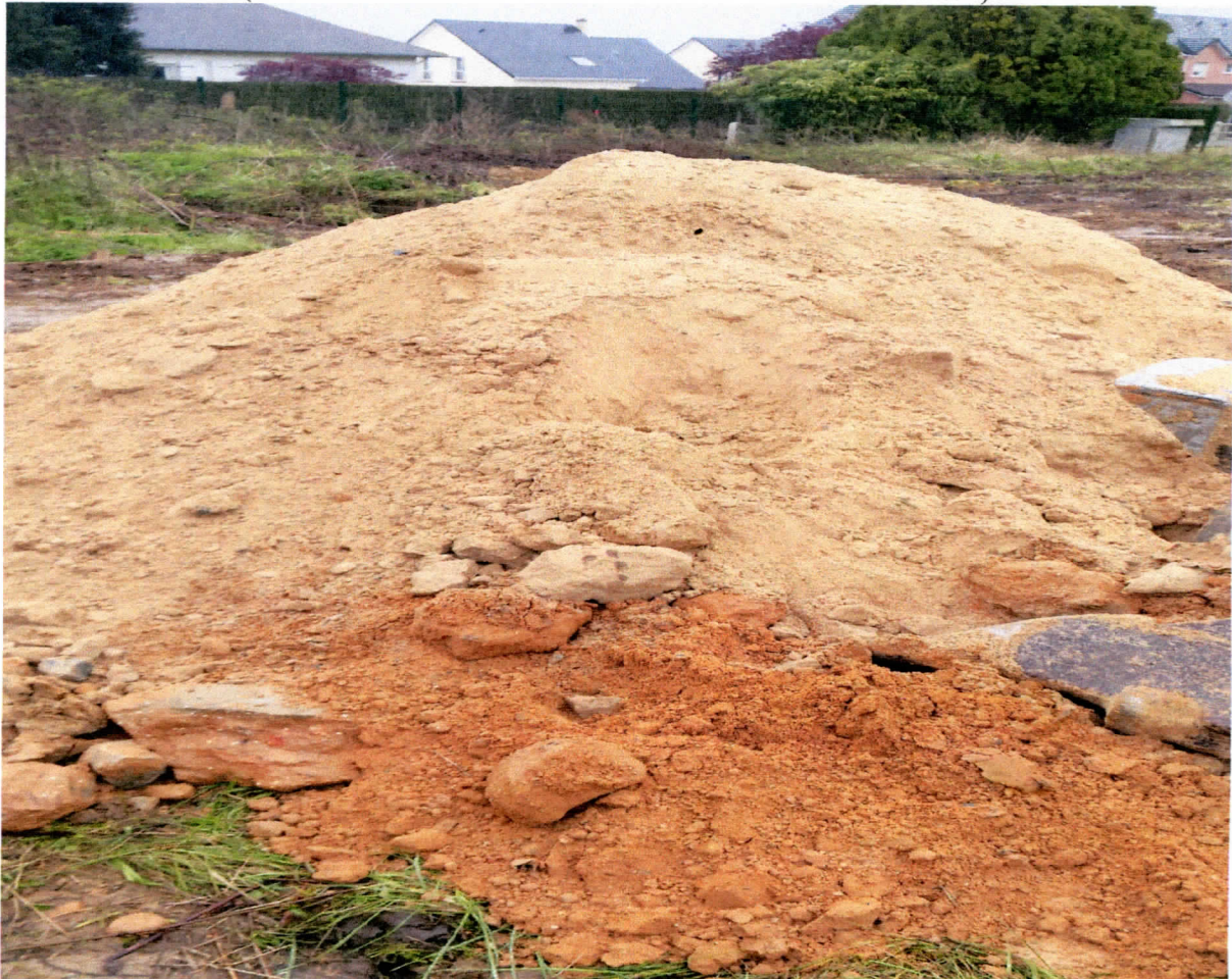
(Photo n° 5 : Matériaux de comblement –Limons traité !).
