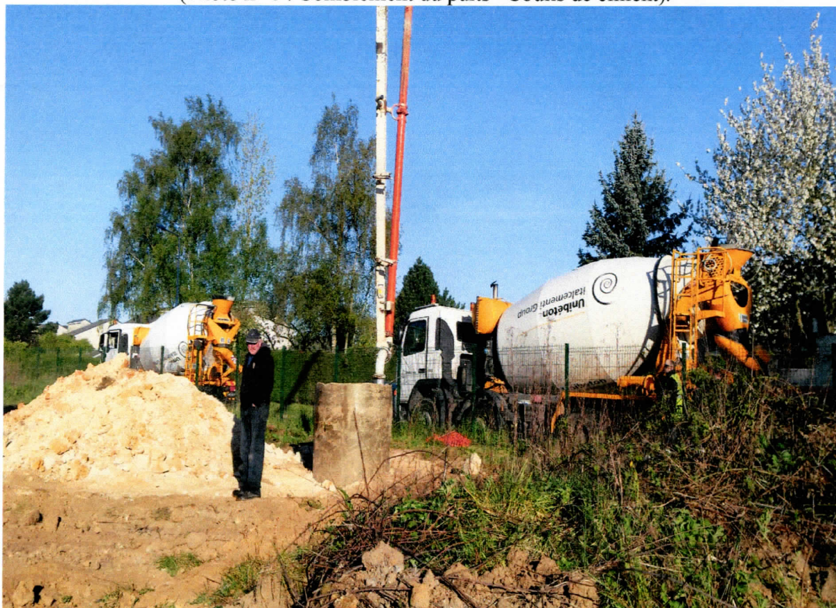
(Photo n° 9 : Comblement du puits –Coulis de ciment).
