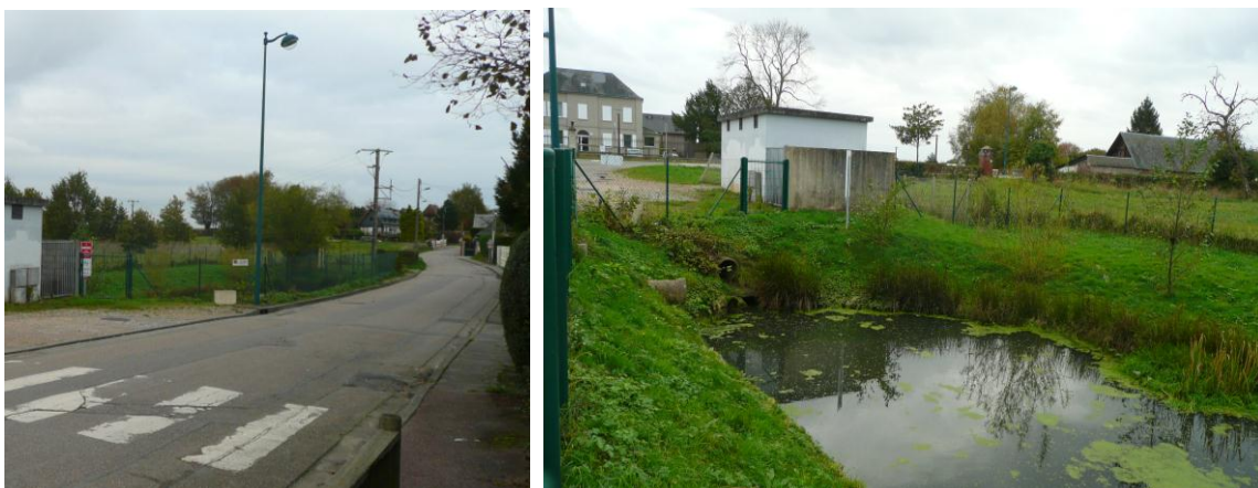
Figure 12 : Bassin exutoire situé rue du Froc aux Moines (BR 151)
