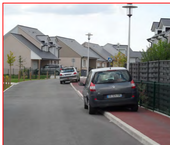
Si les trottoirs servent en pratique au stationnement des voitures, pourquoi continuer à en créer ?
