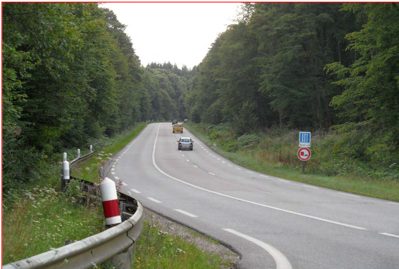
Les routes à grande circulation créent des coupures biologiques à l'intérieur de la forêt
