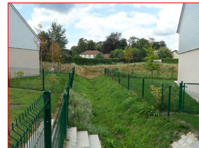
Le Maraval est un fossé qui se remplit d'eau et peut déborder en périodes de fortes pluies
