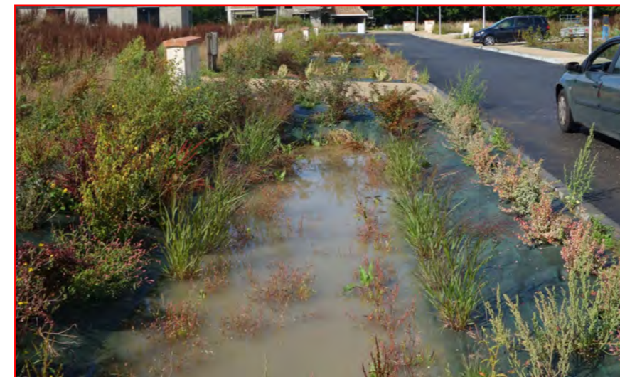
Les opérations d'aménagement récentes intègrent des dispositifs d'infiltration des eaux pluviales
