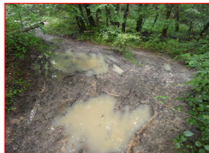
Un chemin forestier dégradé et difficilement praticable
