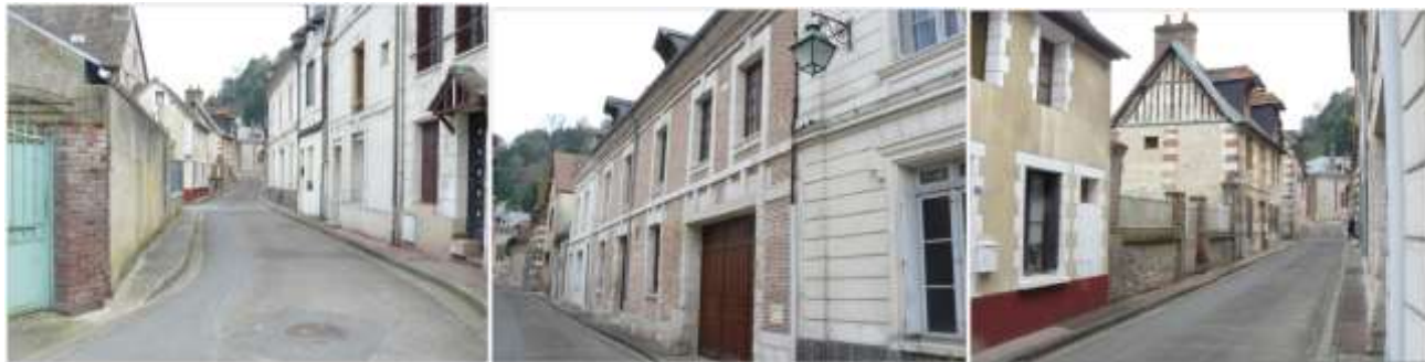
Un bâti ancien caractérisé par un habitat dense souvent implanté en front à rue...
