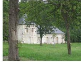
Le toit en ardoises et les murs en pierres de calcaire blanc
