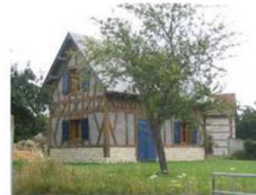
Un bâtiment en cours de restauration
