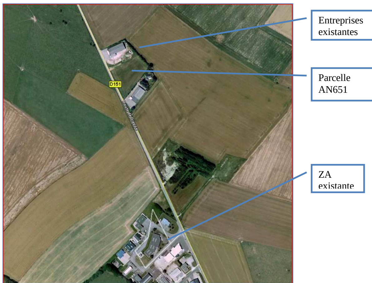
Figure n°1 : Vue aérienne du secteur d'études
