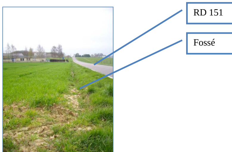
Figure 11 : Vue du fossé bordant la RD 151
