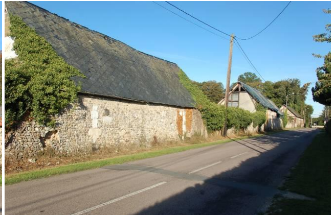
Front bâti sur la route de la Fontaine
