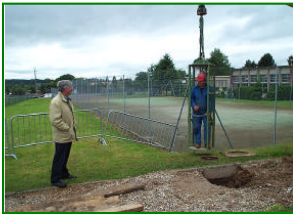
Descente pour inspection de la marnière
