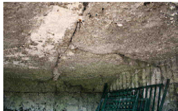
Bloc délimité par des fractures ouvertes en état de stabilité précaire
