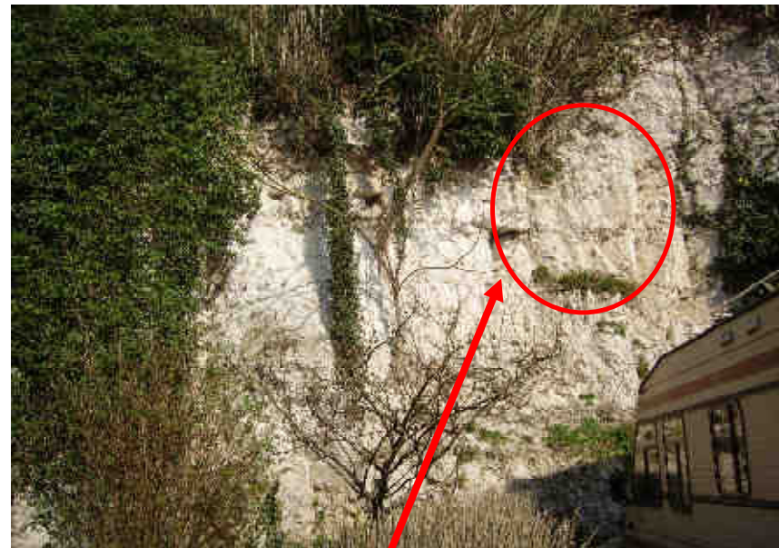
Blocs ou panneaux en surplomb potentiellement instable
