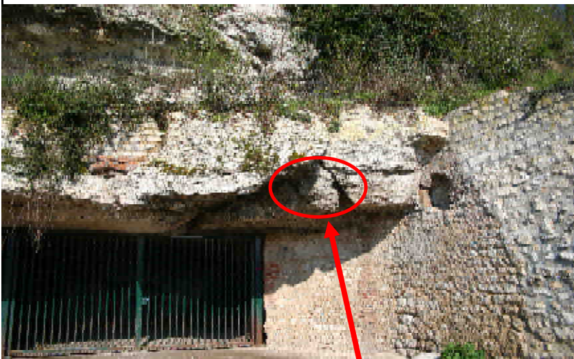
Bloc délimité par des fractures ouvertes en état de stabilité précaire
