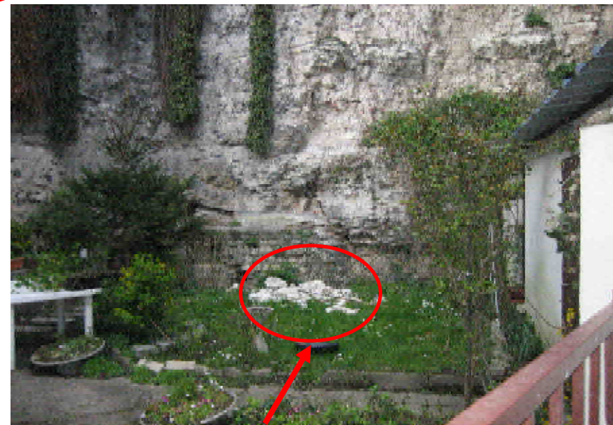
Chutes de blocs en pied de falaise
