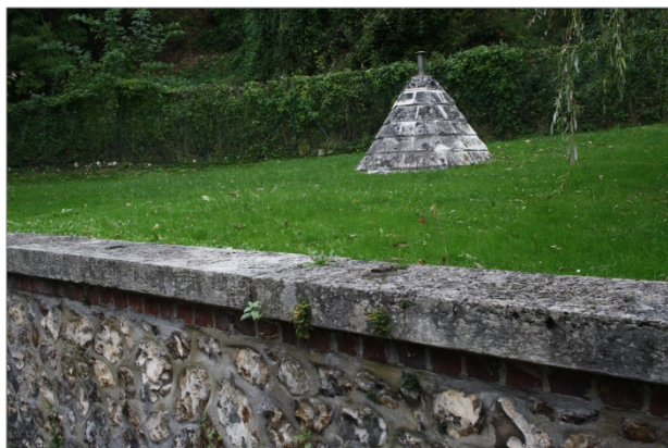
Photo 2 : Captage de Carville (Source : ALISE Environnement)
