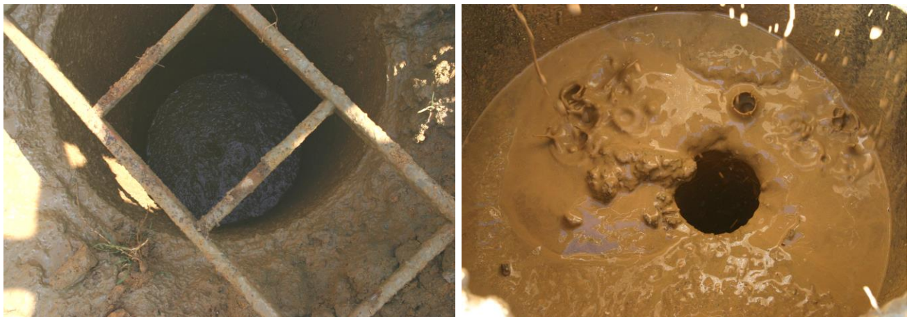
Photographies n° 12: Remblaiement d'une marnière
