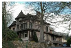
16- Propriété privée - AT 142 - 65 rue Samuel Lecoœur
