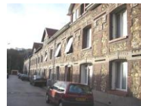
23- Propriétés privées - AS 18 à 28 - Rue Saint Filleul (n° impairs)
