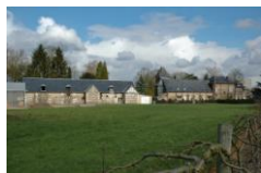
2- Centre Départemental de l'Enfance - AH 59 et 127 - Route de Sahurs
