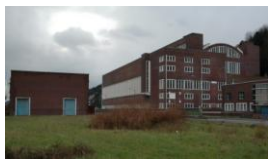
1-Centrale EDF - BH 23 - 44 quai de Danemark
