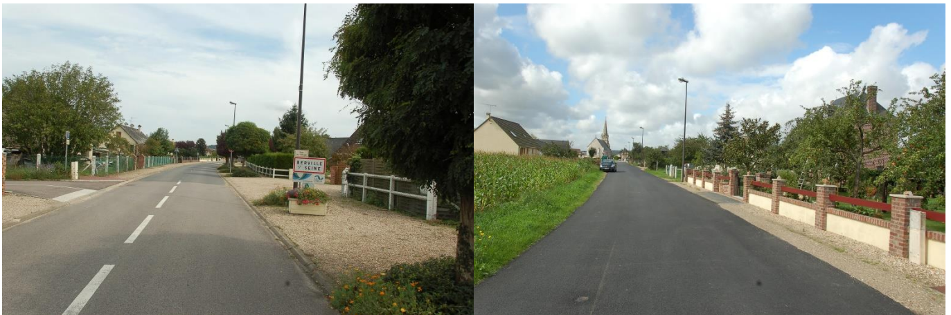
Figures 54 et 55 : Entrées Ouest et Est du bourg de Berville
