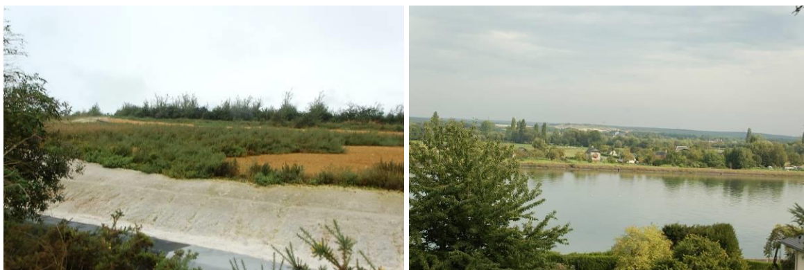
Figures 37 et 38 : Dépôt de phosphogypses / Vue depuis Duclair avec le dépôt émergeant en arrière plan
