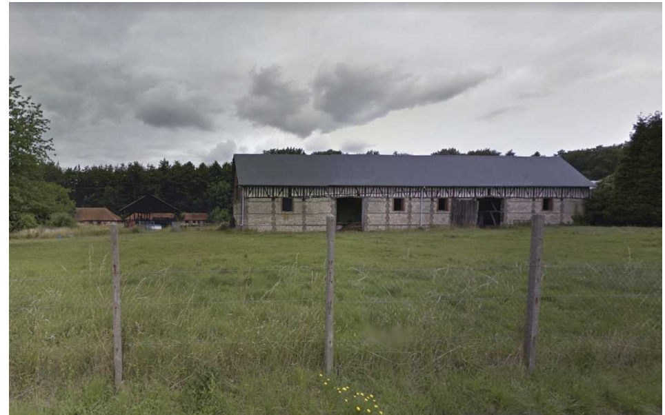
Ancien corps de ferme dont les bâtiments sont protégés dans le cadre de l'OAP « Les Alliés » à Belbeuf
