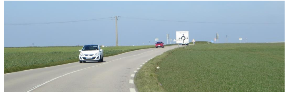
Des infrastructures routières qui créent des coupures dans le paysage (Quèzeville-la-Poterie, source : Even Conseil)
