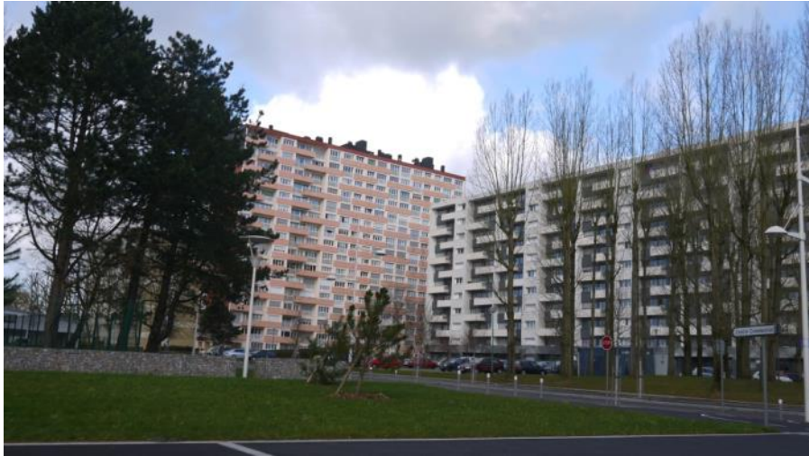
Quartier du Châtelet - Avenue du Maréchal Juin - Rouen – Source : Citadia Conseil
