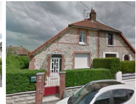
Bâti de cité-jardin, Rouen - Source : Google maps
