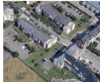
Les Portes de la Forêt, Bois-Guillaume – Source : Google maps
