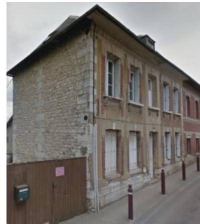
Exemple de maison de bourg - Saint-Martin-de-Boscherville-Source : Google maps
