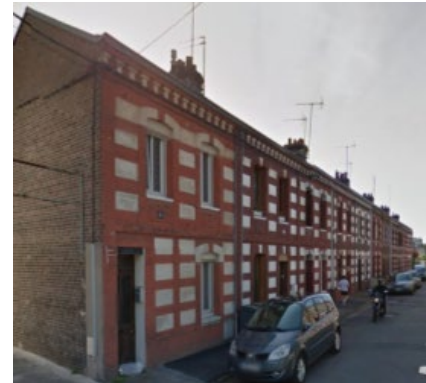
Alignement de maisons ouvrières, rue Boucher de Perthes, Rouen - Source : Google maps
