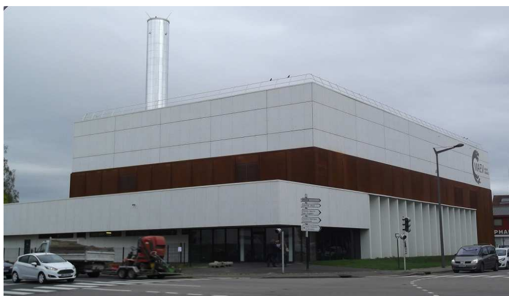
Vue extérieure de la chaufferie ©MRN
