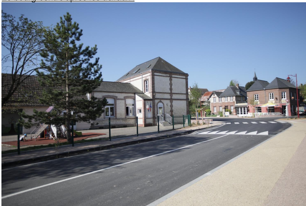
Le bourg-centre après les travaux :
