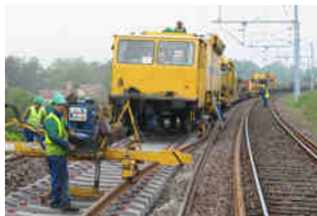
Longs Rails soudés sur traverses béton
