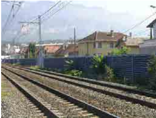
Exemples d'écrans acoustiques à Aix-les-Bains
