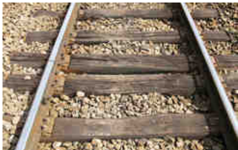
Rails courts sur traverses bois
