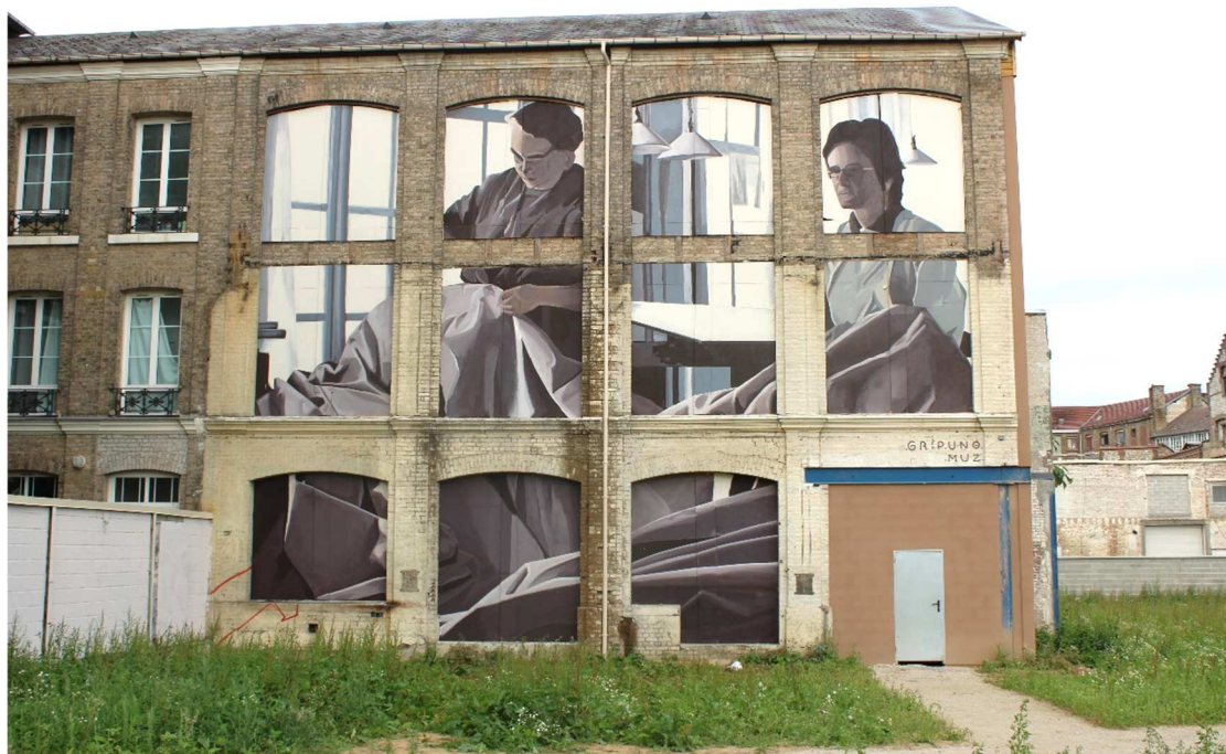
Le « bâtiment 2 », seule construction conservée sur site, et la fresque réalisée en 2021
