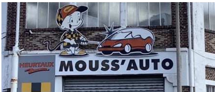
Enseigne parallèle au mur ne respectant pas le rythme des ouvertures sur la façade, Saint-Aubin-lès-Elbeuf
