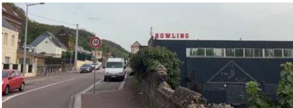
Enseigne sur toiture de petit format en lettres découpées, Amfreville-la-Mi-Voie
