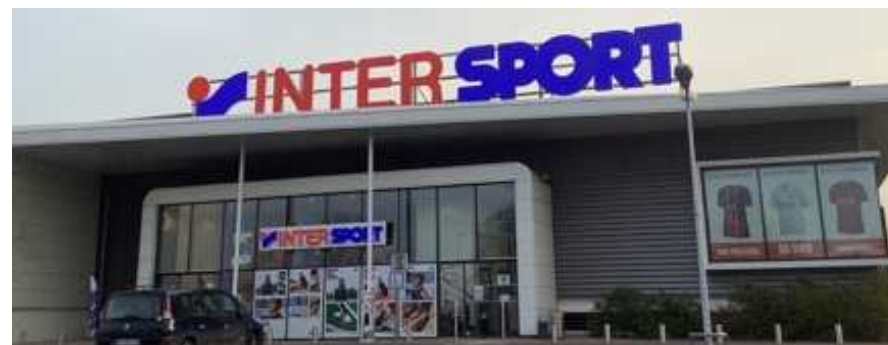
Enseigne sur toiture de format moyen, Tourville-la-Rivière
