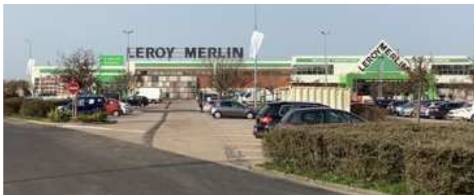
Cumul excessif d'enseignes sur toiture sur panneau et en lettres découpées, Isneauville
