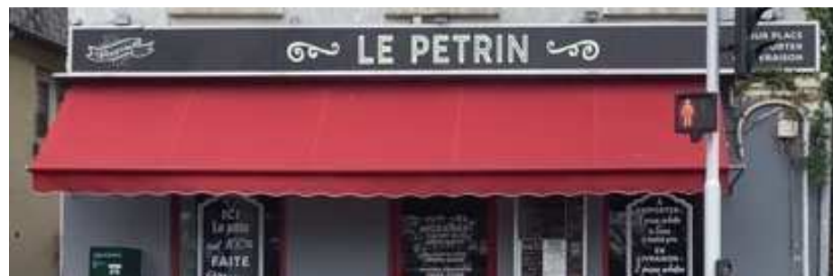
Enseignes parallèles en lettres découpées sur panneau de fond et vitrophanie placée à l'extérieur des baies, Amfreville-la-Mi-Voie
