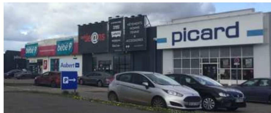
Surface cumulée des enseignes élevée, Tourville-la-Rivière
