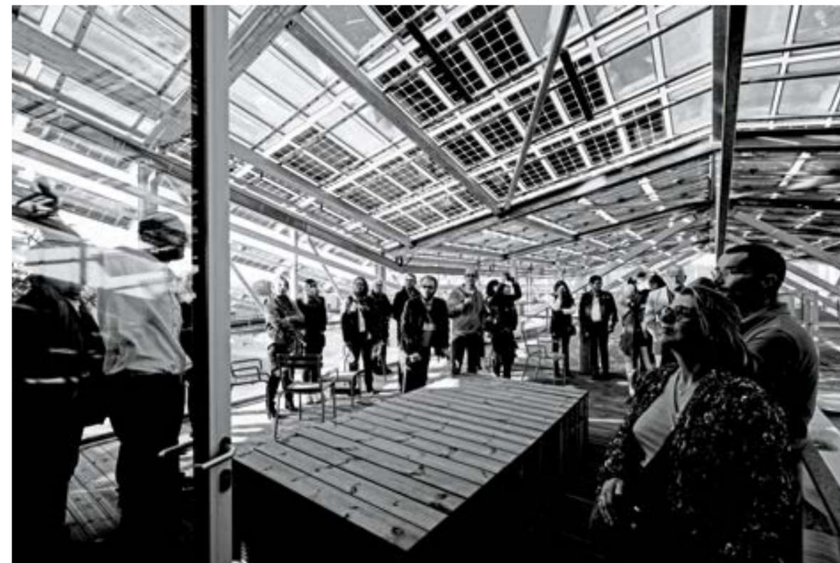
sud ainsi que de panneaux vitrés aux teintes irisés. Si les panneaux photovoltaïques ont pour vocation première de capter l'énergie du soleil afin de produire de l'énergie en partie pour le bâtiment (l'autre partie pouvant être revendue et réinjectée dans le réseau de distribution), cette « double peau » joue également un rôle dans la protection thermique passive des façades.
