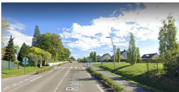
Le CD 928, à la sortie d'Isneauville, équipé d'une piste cyclable.
