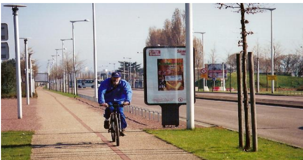
Un exemple de recomposition positive, sur l'avenue des Canadiens : deux pistes cyclables, deux voies TEOR, et une seule file par sens.
