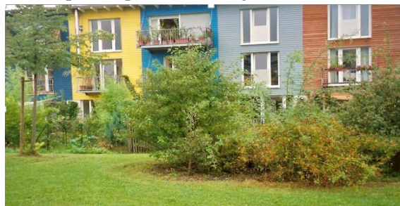
Rieselfeld : maisons en bande ouvrant sur un jardin collectif.
