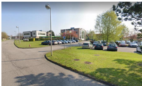
Mont Saint Aignan : parc d'activités de la Vatine. Les parkings consomment davantage de surface que les bureaux.
