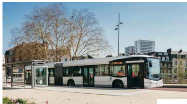
2019 : mise en service de la ligne T4 du système TEOR.
