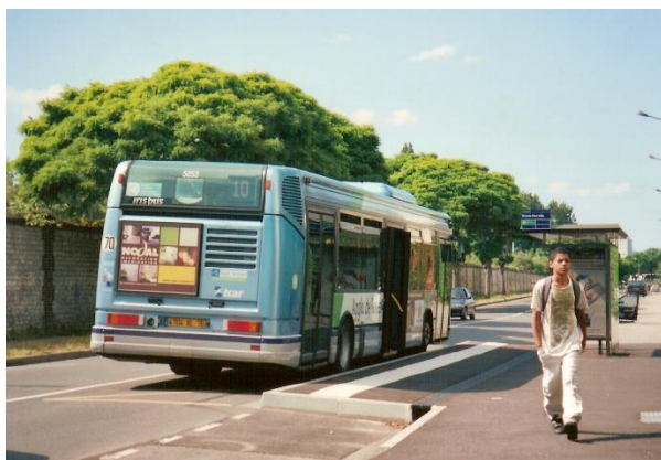
Une station de bus accessible à quai surélevé et avancé : un dispositif permettant l'accessibilité du bus aux PMR / UFR.
