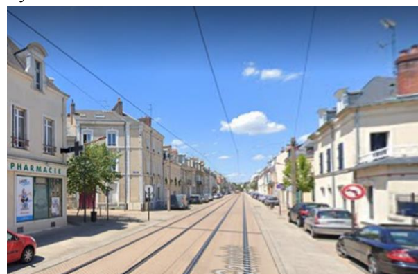
Le Mans, rue Gambetta : circulation en site partagé, stationnement latéral tenu à distance du tramway.
