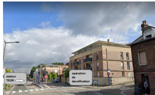
Densification sur le tracé de T2, à Déville-lès-Rouen.
