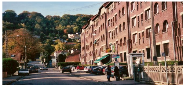
Réparer un tissu urbain fonctionnellement lacunaire : introduire les emplois et les commerces qui font défaut (Grieu)
