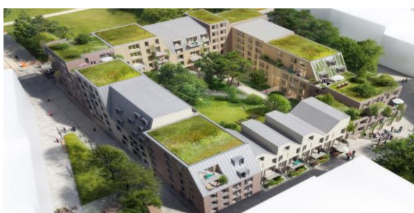
Lille, rénovation de la friche ferroviaire Saint Sauveur : un îlot dense, mais des formes variées et une forte végétalisation.
