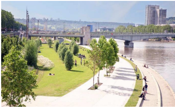
Quais rive gauche : un parking transformé en jardin.
