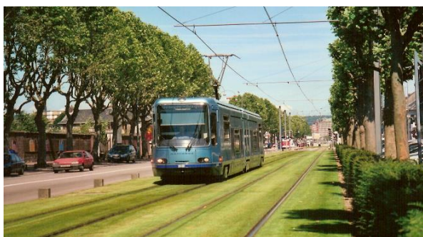
1994 : mise en service du tramway.
