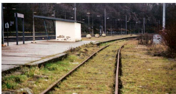
En gare de Barentin, et l'ancien terminus de la ligne de Duclair : un espace disponible pour la création d'un faisceau de trois voies.
