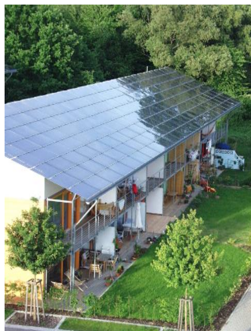
Freiburg im Brisgau, écoquartier Vauban : petits collectifs à énergie positive mettant également en application les principes du bioclimatisme.
