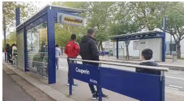
Des lignes FAST upgradées, avec des stations de type BHNS.
