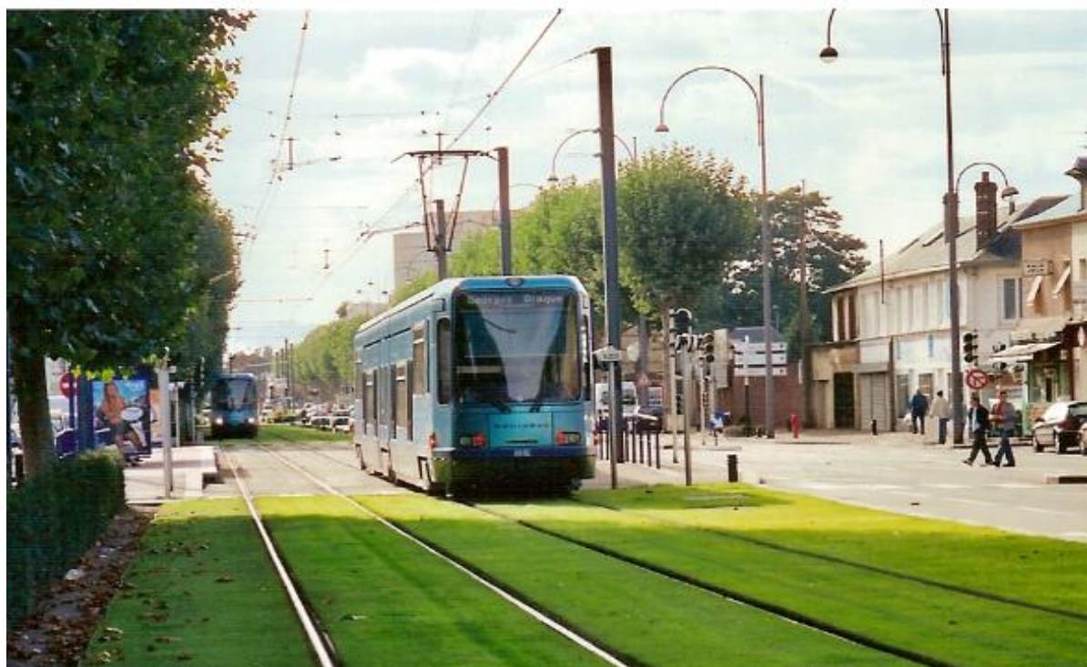
La venue du tramway à Petit Quevilly en 1994 : une route urbaine bruyante transformée en une avenue apaisée.
