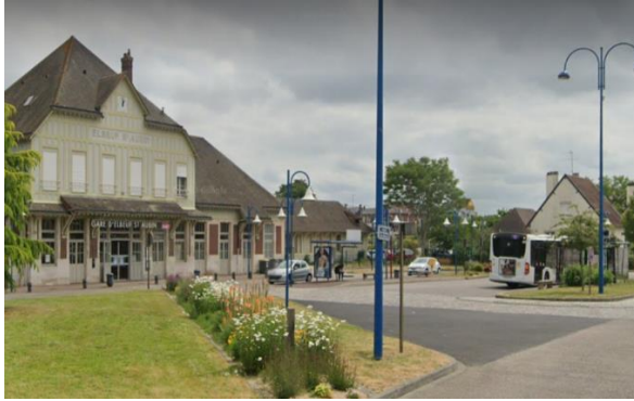
La gare d'Elbeuf Saint Aubin et la station de bus attenante.
