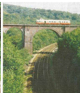
La ligne Rouen – Elbeuf sur le viaduc des Sept Arches.
