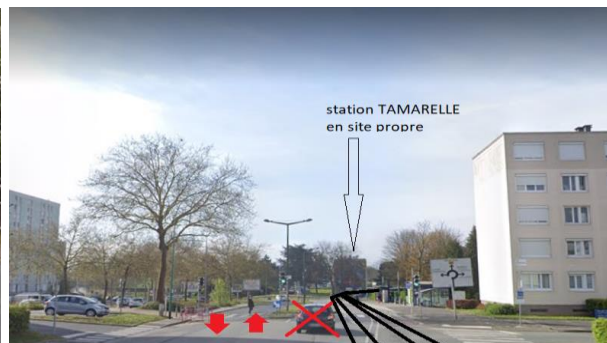
Le terminus, sur la chaussée ouest de la rue A. Daudet.
