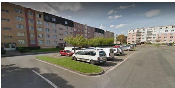
Bihorel, plateau des Provinces. Un paysage bitumé, peu convivial et promis à la surchauffe. Nécessité de contracter la place de la voiture et de végétaliser. Nécessité d'équiper les stationnements de bornes de recharge.
