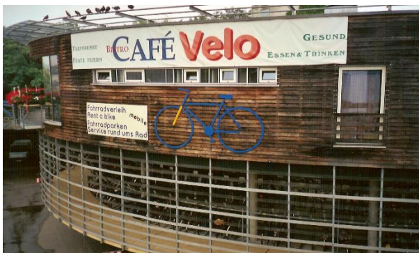
Mobile : la centrale de mobilité de Freiburg im Brisgau. Localisation : centre-ville, point nodal du réseau (gare + tram). Agence tous modes, garage et maintenance vélo, lieu de rencontre.
