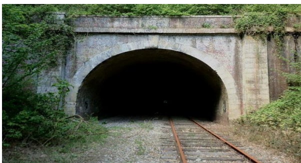
Moulineaux : entrée du tunnel de Maredotte.
