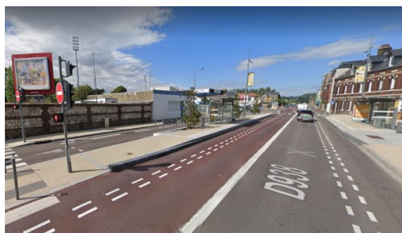
Station CAF, configurée en chicane : les bus se déportent à l'entrée et à la sortie de la station.
