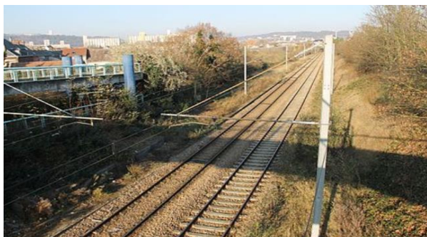
La section à double voie électrifiée, à Petit Quevilly
