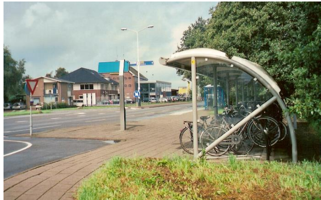
Station de bus express aménagée sur une route principale Aux abords d'un village néerlandais, dans la périphérie de Gouda.
