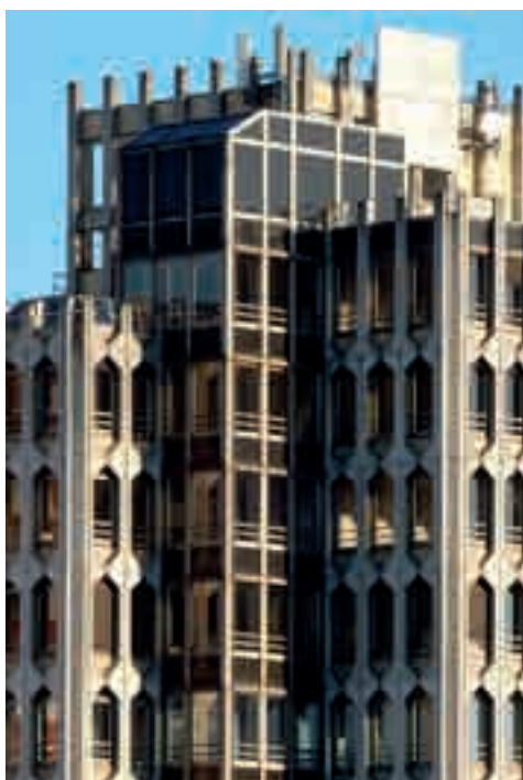
Détail de l'immeuble aujourd'hui © Mai Diep
