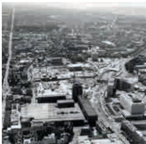
Construction de la trémie Saint-Sever, en 1977. Elle entre en service le 30 janvier 1978. Le boulevard de l'Europe est encore à l'étude © Collection Guy Pessiot
