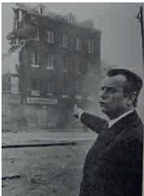
Le maire Jean Lecanuet assiste à la démolition de l'immeuble, 74 rue du Pré, printemps 1974
