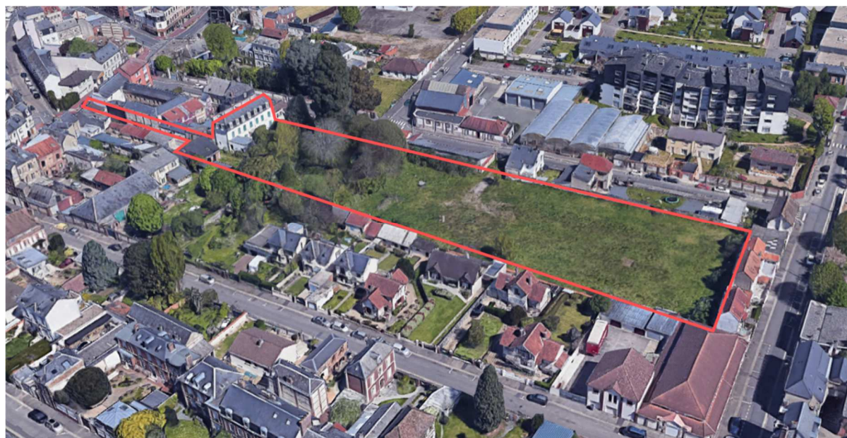
Le site Chanzy et son environnement immédiat (source : Google Maps)
