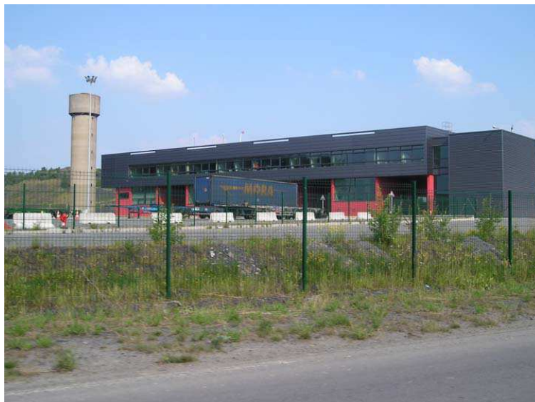
Bâtiment opérateurs en entrée de terminal portuaire – photo Delta 3
