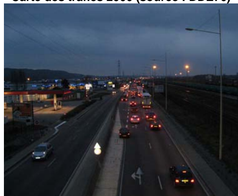
D18E au niveau du carrefour des quatre mares
