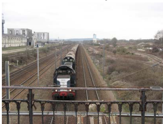
Voie ferrée depuis le chemin du pont de la Chapelle
