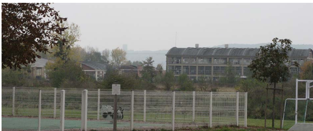
Vue sur un bâtiment de YORKSHIRE (à l'abandon)
