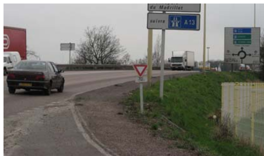
Interruption de la piste cycle au niveau du franchissement de la voie ferrée (carrefour Grasset)
