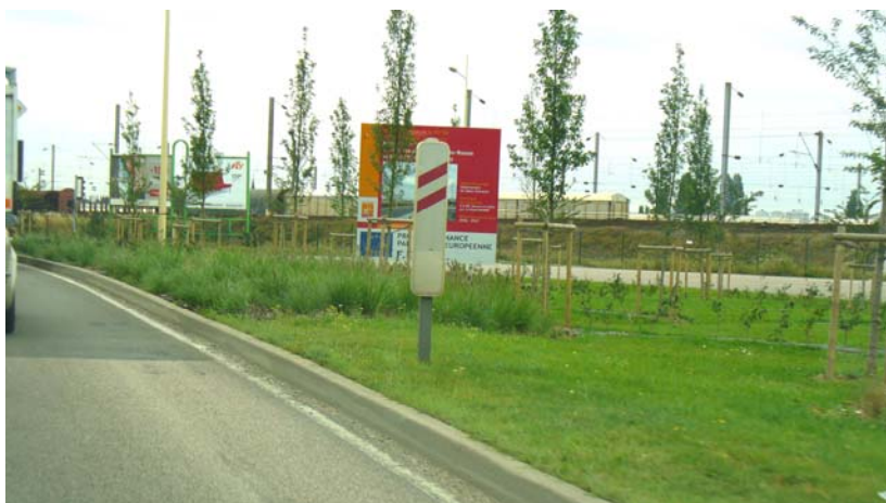
Quelques aménagements liés à la requalification de le RD18E
