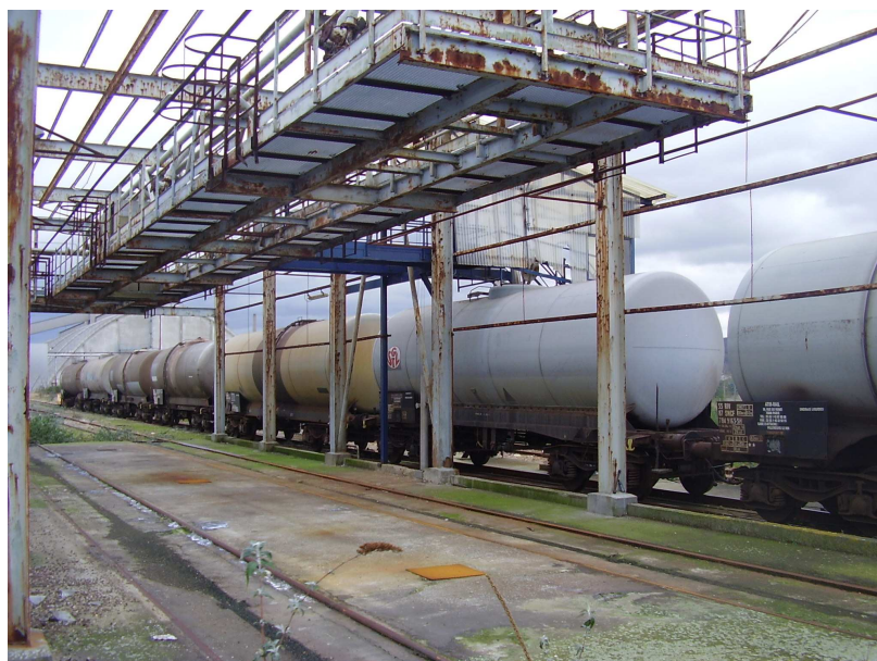
Photo 4 : portique de chargement de camions citernes et de wagons du site SCO – (Eurotrans)
