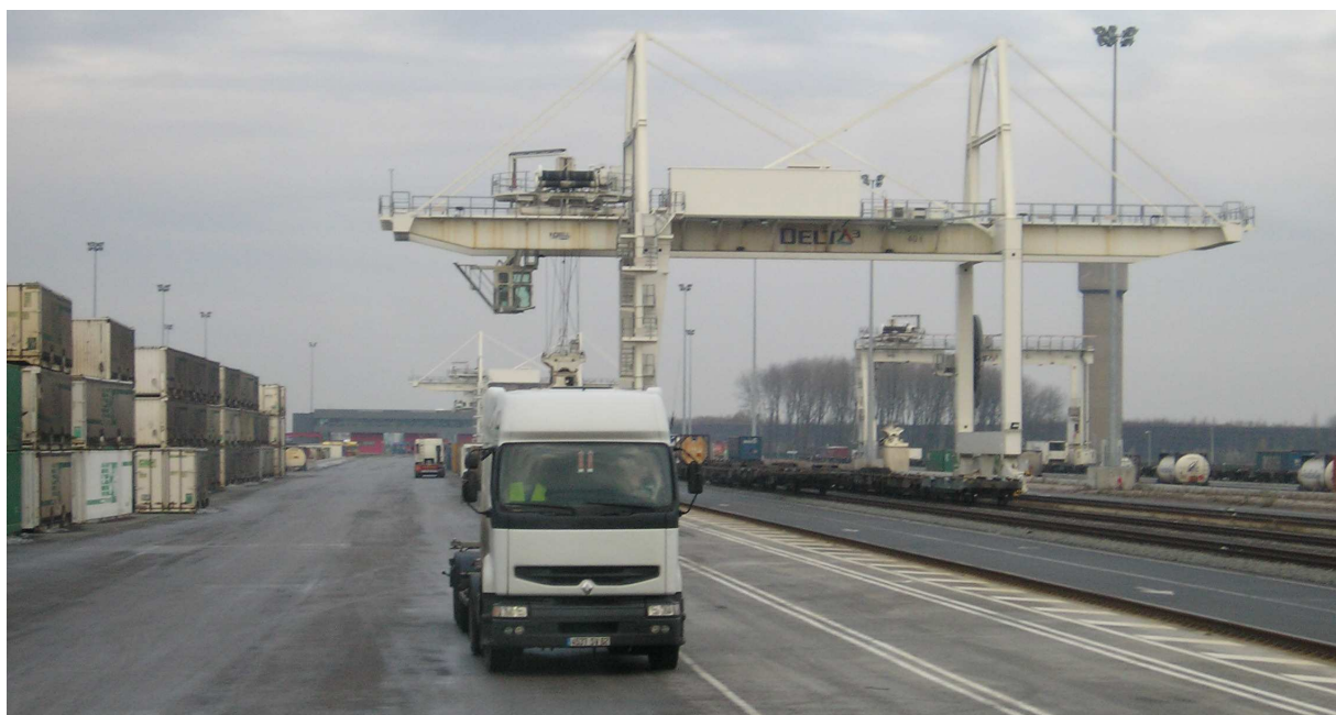
Photo 21 : Vue de la partie rail-route de la plate-forme rail-route Delta 3 (eurotrans.fr)
