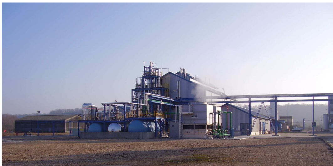
Photo 12 : nouvelle unité de production Francolor – investissement de 20 M€ en 2006
