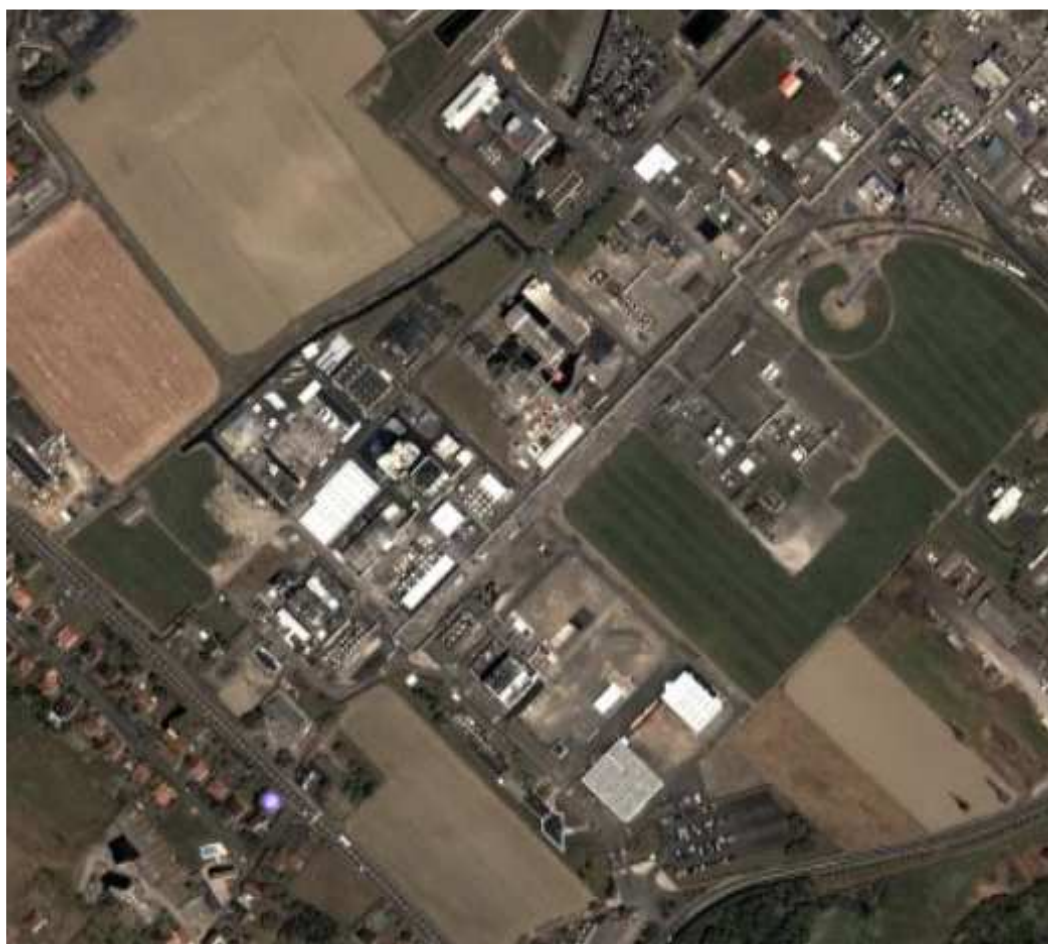
Photo 13 : vue aérienne de la plate-forme chimie fine de Mourenx (droits Google)
