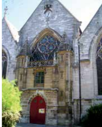
Portail de l'église Saint-Vivien
