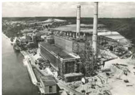
La centrale électrique de Yainville, vers 1948 (sur cette photo on voit Yainville II en cours de construction)
