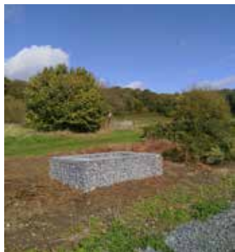
Gabion sur le bord de la voie pouvant servir de refuge à la biodiversité présente
